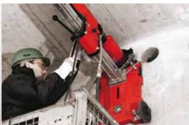
Evita el acero de refuerzo: Evitando cortar y dañar las estructuras armadas al momento de perforar o extraer muestras.
